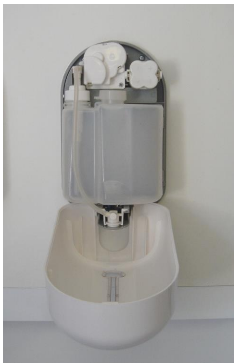
For påfyldning af sæbe/væske åbnes fronten af kabinettet, og beholderen kan let tages ud og skylles godt inden sæbe/væske hældes i den gennemsigtige beholder. Anvend tragt, så der ikke spildes sæbe andetsteds i dispenserens.
